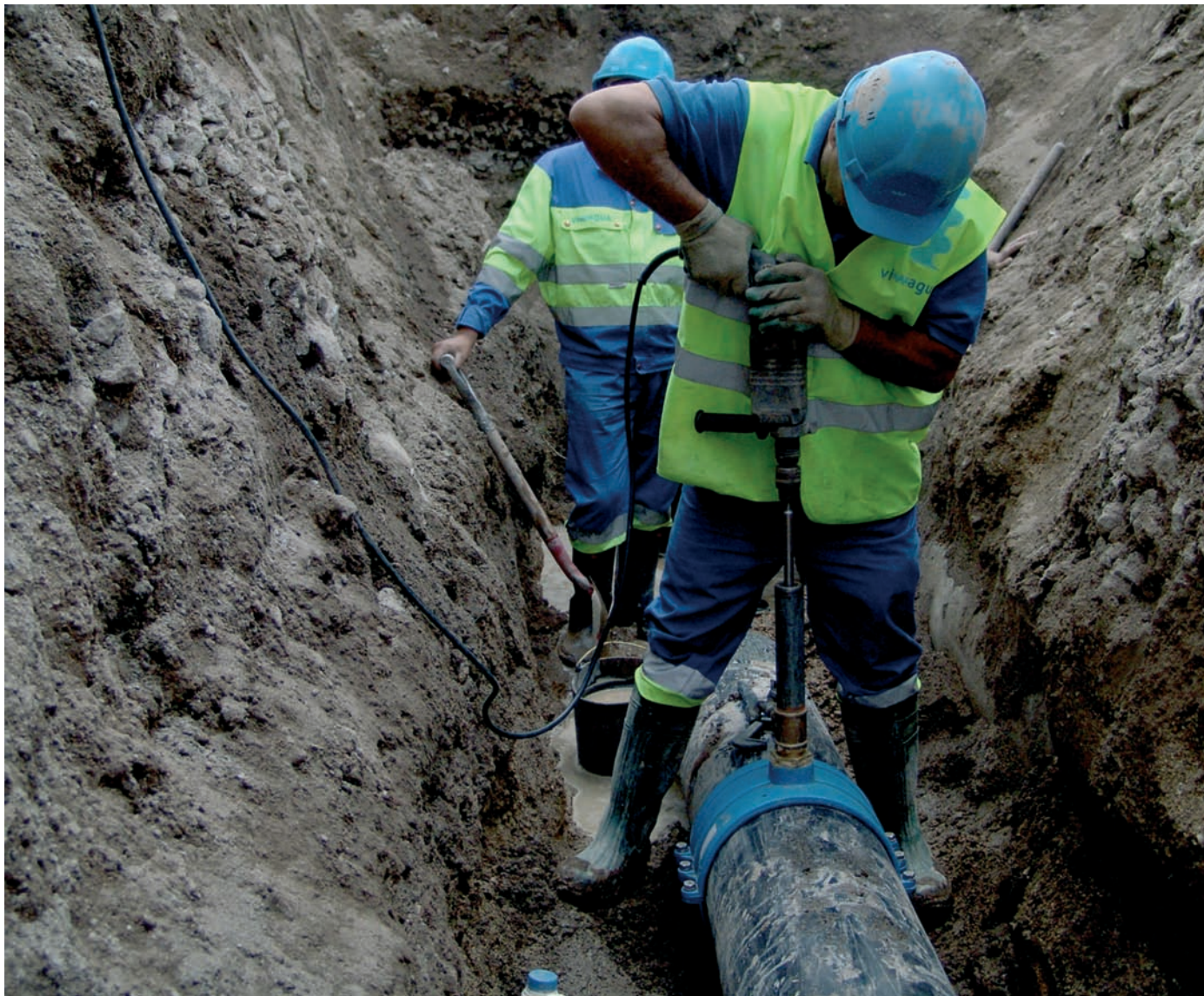
Operação de Reparação da Conduto Adutora/ Distribuidora
