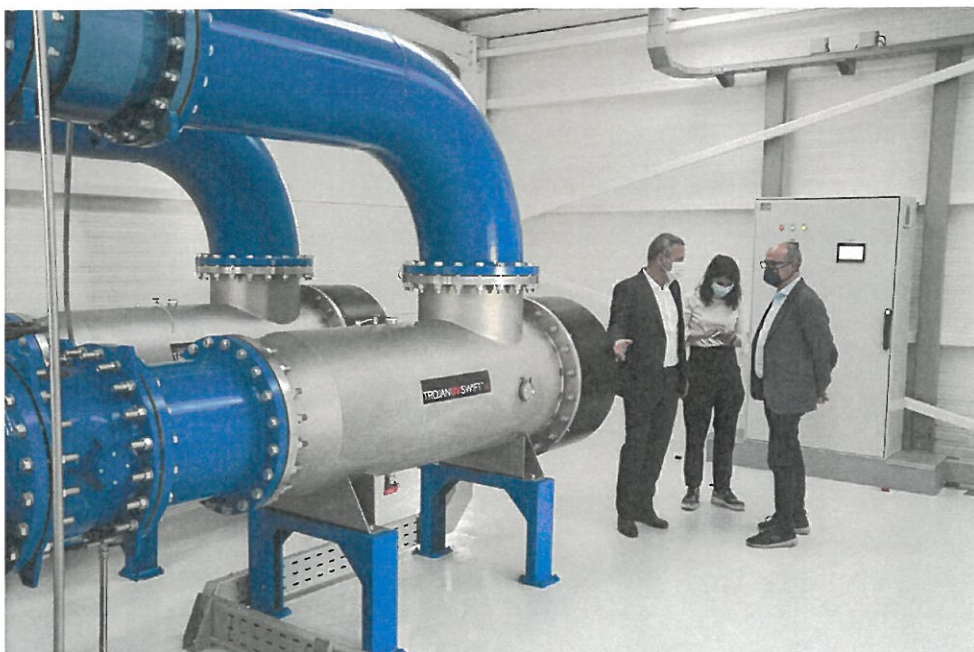
22 de março 2021 - ETA Vimágua
